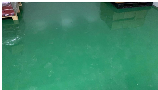
危废仓库地面防渗措施
