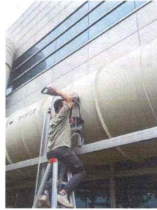
FQ-606832 废气处理设施出口
