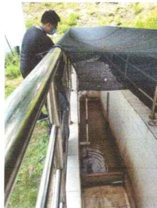
生活污水排放口
