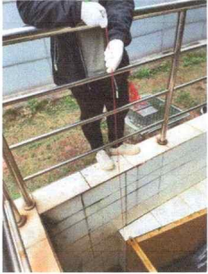
综合废水排放口
