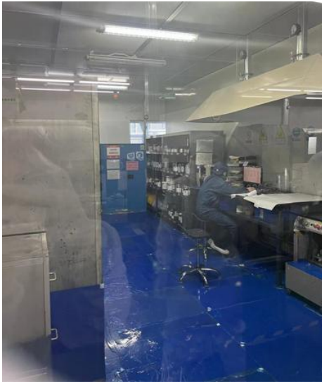
车间地面防腐防渗措施
