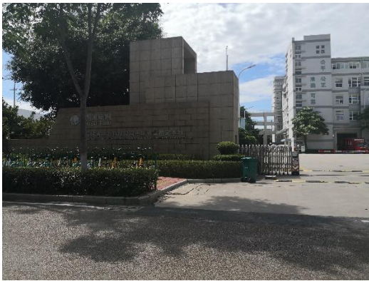
电力公司电能计量检定基地
