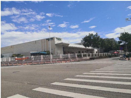
施耐德公司 AVX-E 厂区
