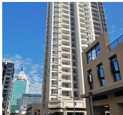
项目一期现状图
