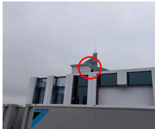
柴油发电机废气排放口
