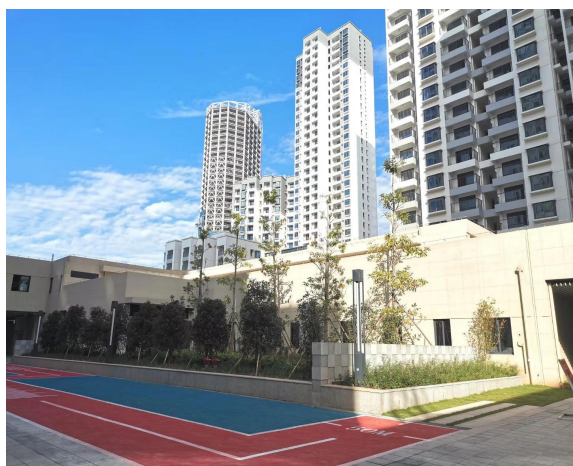
项目一期现状图
