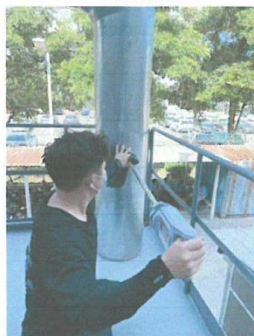
DA012 废气处理设施进口
