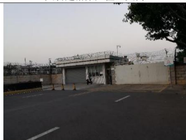
项目东侧太古六期工程
