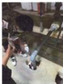
含银废水预处理设施进口 (DW002)
