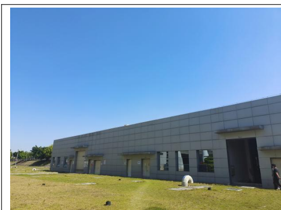
祥达一期污水处理站
