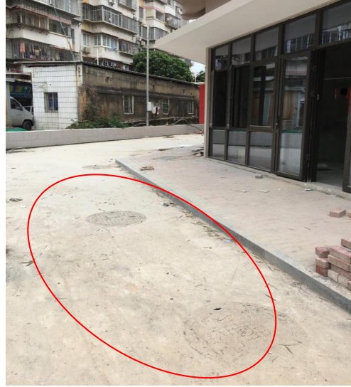
2#西北角化粪池
