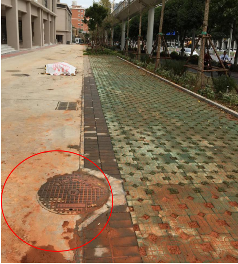
6#楼南侧化粪池
